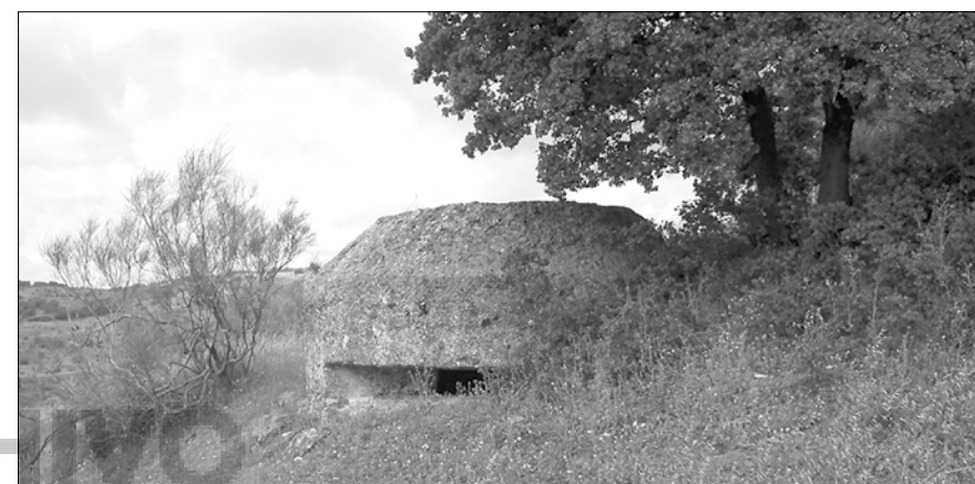
Fortín tipo cilíndrico muy al sur de Valdemorillo. Estas obras se realizaron entre mediados de 1938 y el final de la guerra, de hecho, muchos no se llegaron a concluir.
