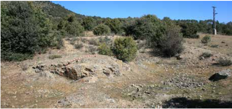
Excavación para el blokhaus n.º 15
