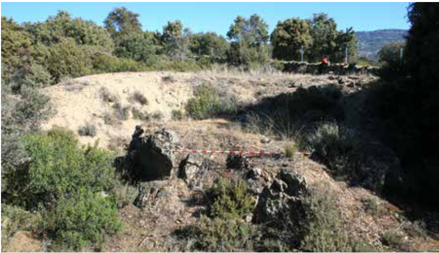
Excavación para el blokhaus n.º 7
