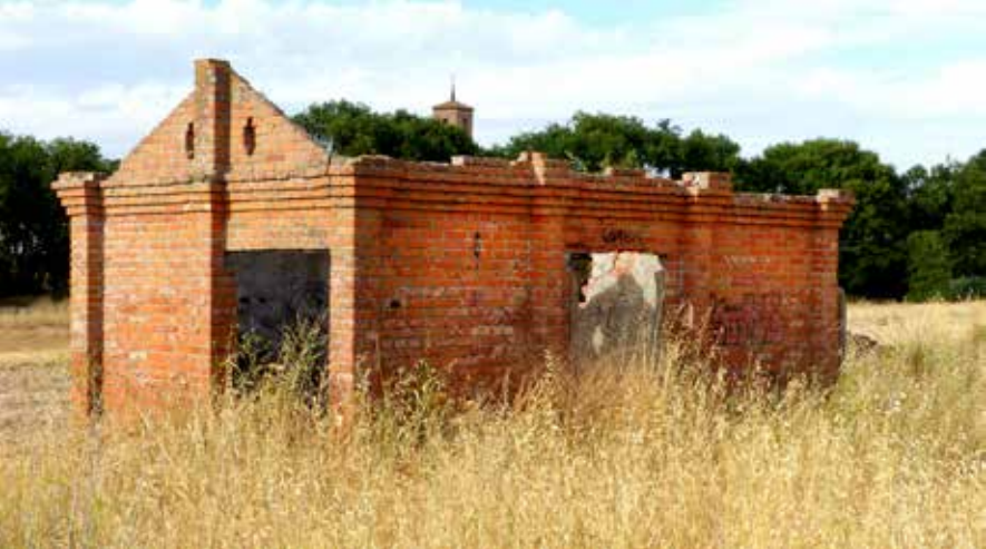
Restos de la estación de Pozuelo de la República actualmente.
