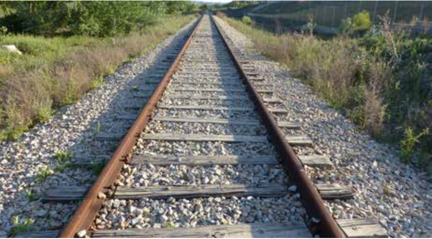
Tramo de vía conservado actualmente a la salida de Torrejón de Ardoz.
