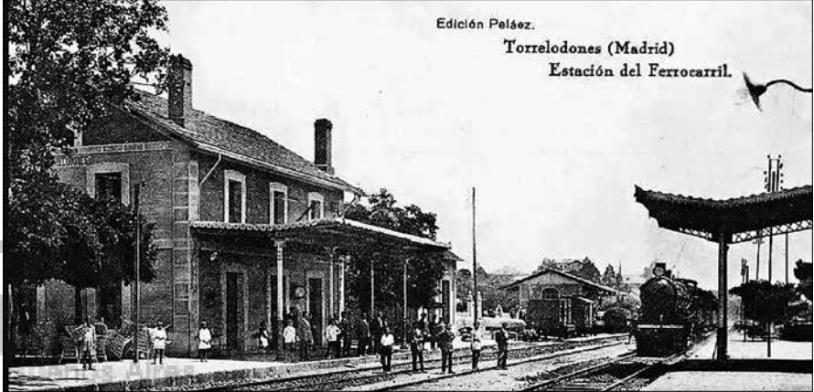
En la estación de ferrocarril de Torrelo-dones se establecería el Puesto de Pando de la 10. a División.
