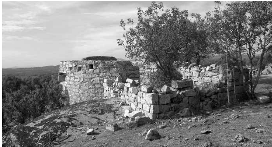
Hay fortines tipo Quinto Regimiento, como este cercano a Valdemorillo, que llevan añadido un habitáculo rectangular construido con los materiales del lugar pero de peor obra, suponemos se trata de un alojamiento.
