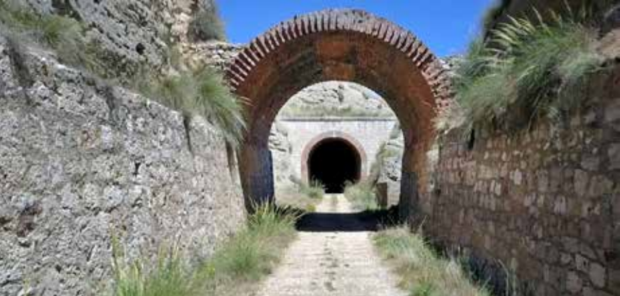
En primer plano, túnel inacabado n.º 15; al fondo, boca de salida del túnel n.º 14.
