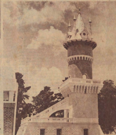
TORRE DE AGUA: Monumental construcción que con su depósito de gran capacidad garantiza el suministro de agua en todo el territorio que abarca el campo de deportes (70 hectáreas) y el funcionamiento de las aguas del lago artificial y de la gran piscina de natación.
