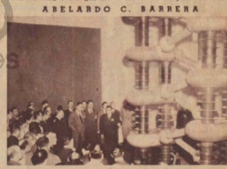
Una vista del generador de alta tensión tipo Cockcroft-Walton, fabricado totalmente en nuestro país por la Comisión Nacional de la Energía Atómica en cumplimiento de los objetivos determinados para sus tareas: el bienestar de la población y no su destrucción.
