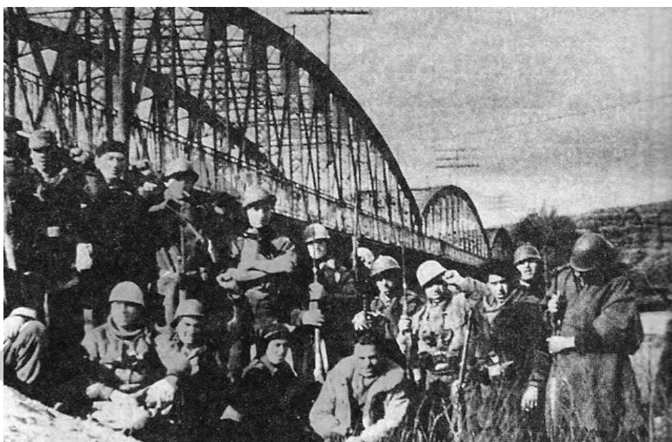
-Imagen nº9: brigadistas en la defensa de los puentes sobre el Jarama.
